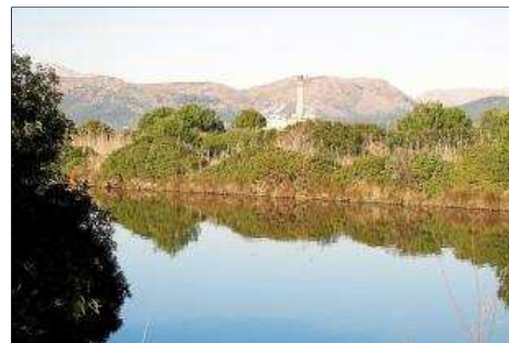
Das Elektrizitätswerk Es Murterar im Hintergrund bildet die unvermeidliche Kulisse der Albufera.
